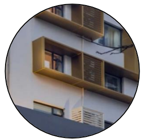
冷凝水管采用粉刷的形式与墙体相结合
