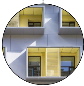
将洞与空调机位用铝板包裹成窗套
