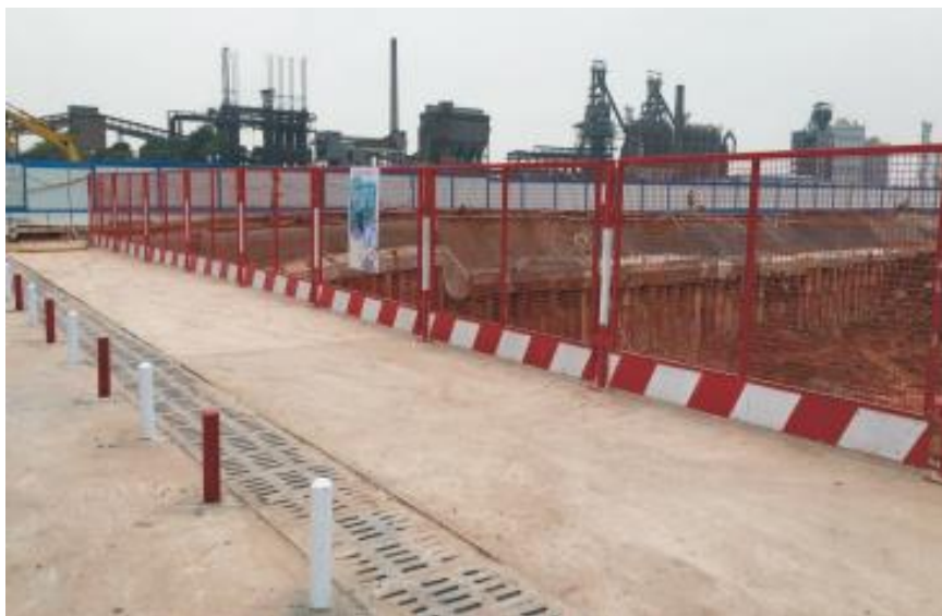
基坑临边防护实景图
