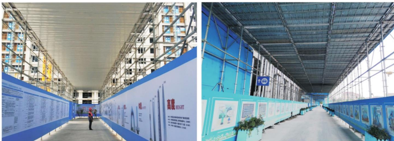
盘扣式脚手架防护通道
