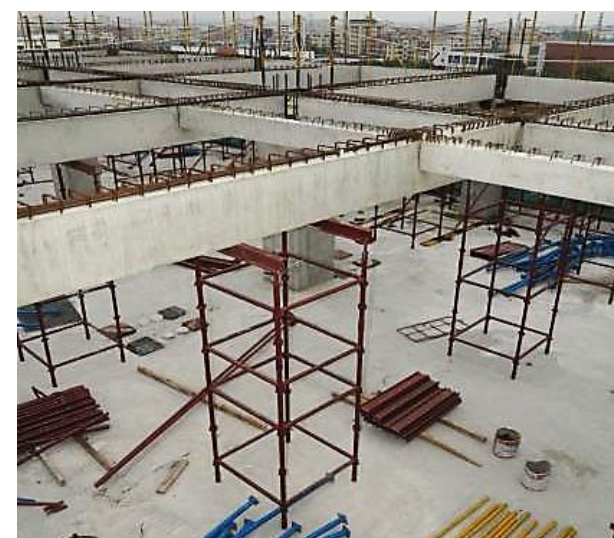
预制梁临时支撑
