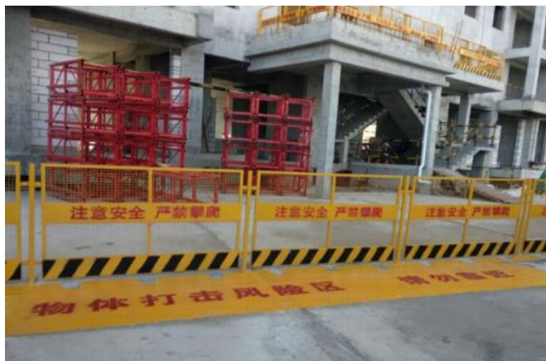
防坠区域隔离防护实景图 (二)
