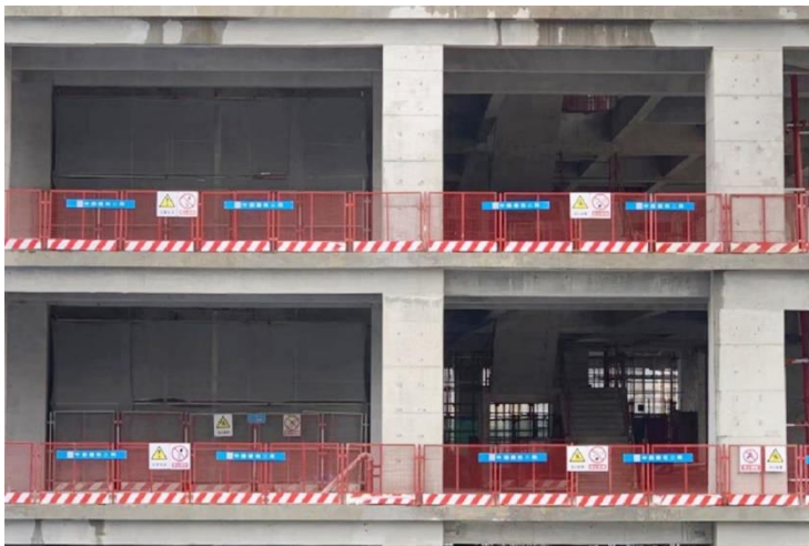
楼层临边定型化防护实景图
