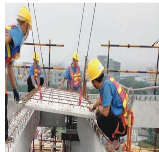
安全栏杆实景图
