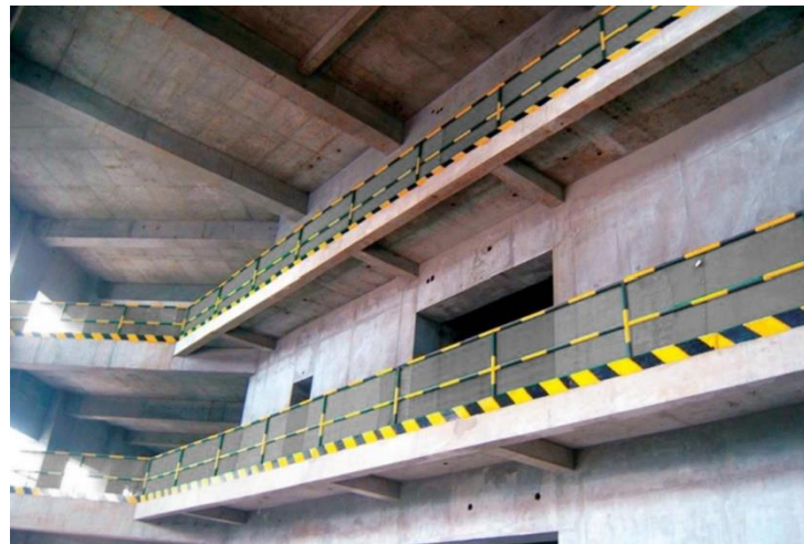
楼层临边钢管防护实景图
