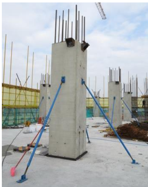
预制柱临时支撑
