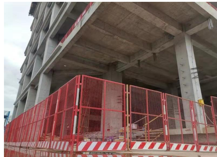
防坠区域隔离防护实景图 (一)
