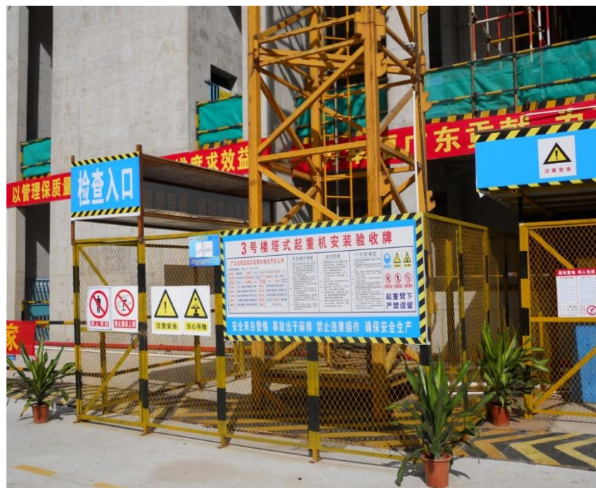
塔吊底部防护栏杆
