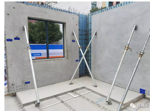
预制剪力墙临时支撑
