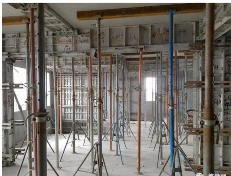
预制楼板临时支撑
