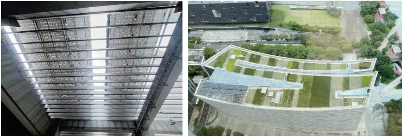
◎ 太阳能光伏发电应用
