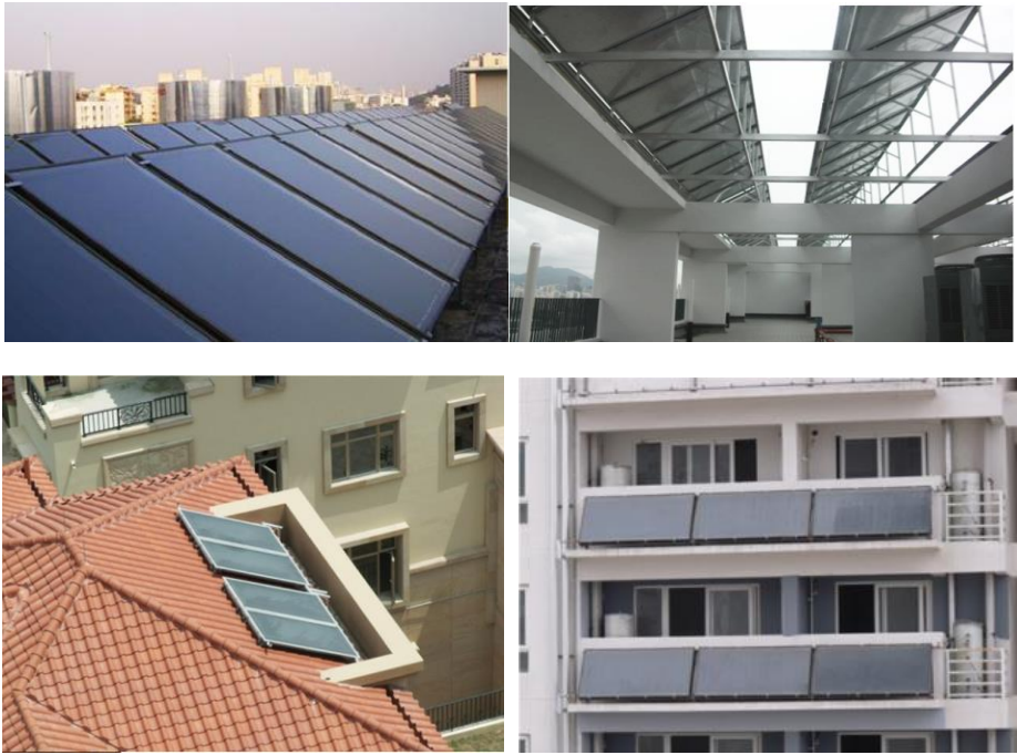
图 4.1-3 建筑太阳能光热一体化设计实例
