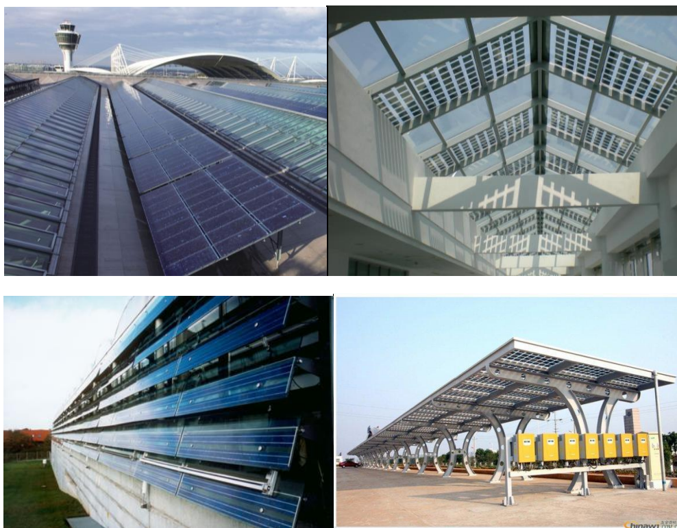
图 4.2-1 太阳能光伏建筑一体化实例
